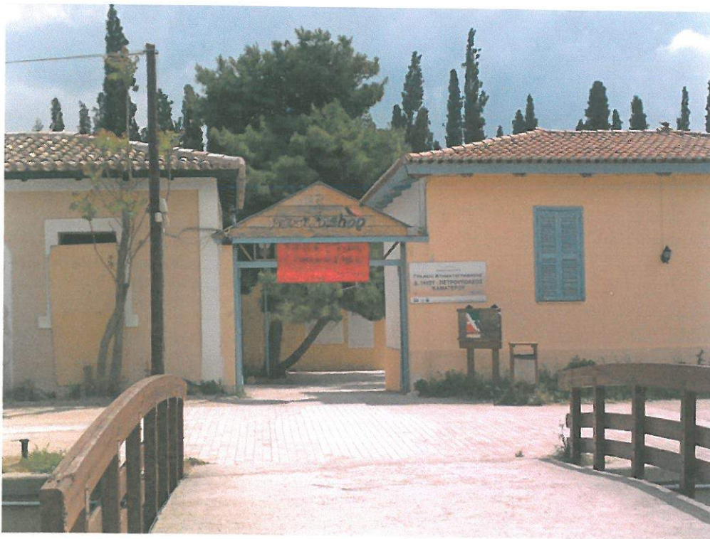
Κτίρια που η ανακαίνισή τους είναι σε εξέλιξη
