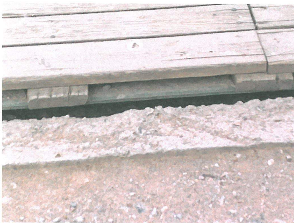
Κεντρική γέφυρα στον τεχνικό αύλαμα νερού
