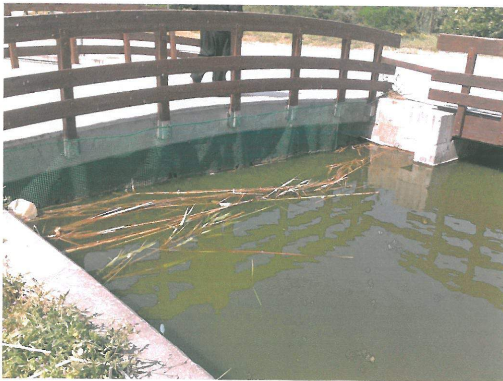
Τετμεντένα γέφυρα στον τεχνητό λώλαμα νερού
