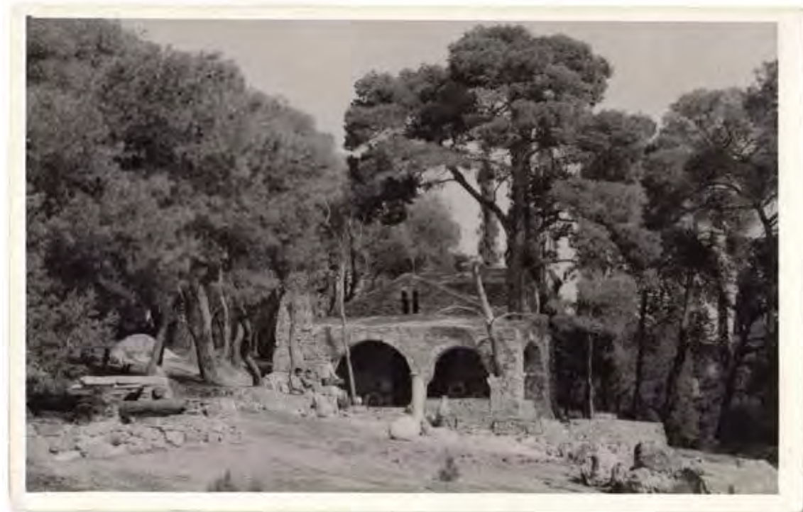
15. Φωτογραφία Ναού Απ. Παύλου κατά την κατασκευή του έργου από νοτιοδυτική γωνία, άγνωστη ημερομηνία (Αρχείο Αγνής Πικιώνη, Αθήνα)
