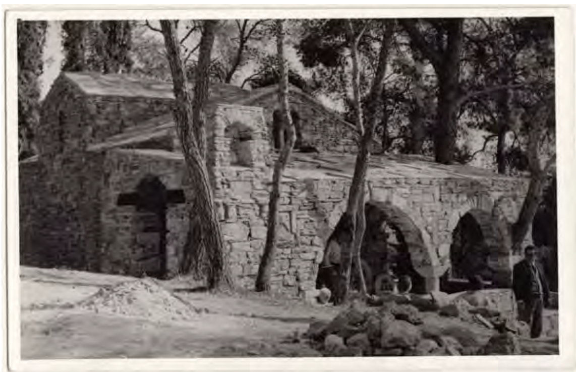
16. Φωτογραφία Ναού Απ. Παύλου κατά την κατασκευή του έργου από βορειοδυτική πλευρά, άγνωστη ημερομηνία (Αρχείο Αγνής Πικιώνη, Αθήνα)
